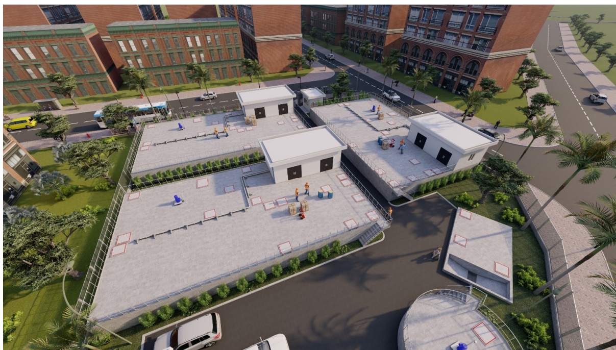
HỆ THỐNG XỬ LÝ NƯỚC THẢI DỰ ÁN NGÂN HIỆP – HỒ TRÀM – CÔNG SUẤT 500 M 3 /NGÀY.ĐÊM
