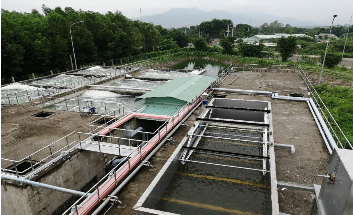
HỆ THỐNG XỬ LÝ NƯỚC THẢI KHU TIỂU THỦ CÔNG NGHIỆP HÒA LONG – CÔNG SUẤT 750 M 3 /NGÀY.ĐÊM
